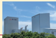
▲スプレードライヤー6号機 (建屋右側)
