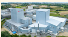
井村屋フーズ 七根サイト 工場外観
